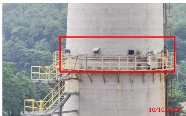
รูปที่ 2 - 14 ระบบ CEMS ที่ปล่องระบาย
