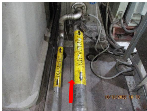
รูปที่ 2 - 64 ระบบท่อน้ำมันเลี้ยงเครื่อง ของ Turbine&Generator
