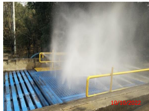
รูปที่ 2 - 37 ระบบการพ่นละอองน้ำเพื่อป้องกัน การฟุ้งกระจายของถ่านหิน
