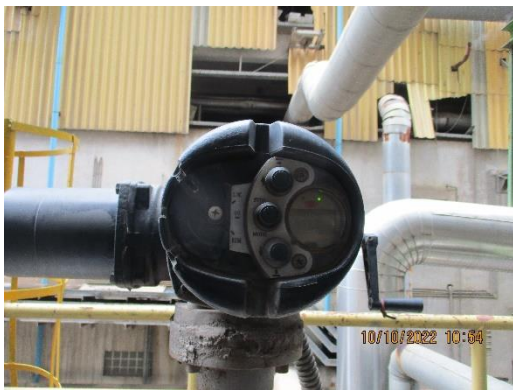
รูปที่ 2 - 60 การตรวจสอบระดับน้ำแบบ Electrode
