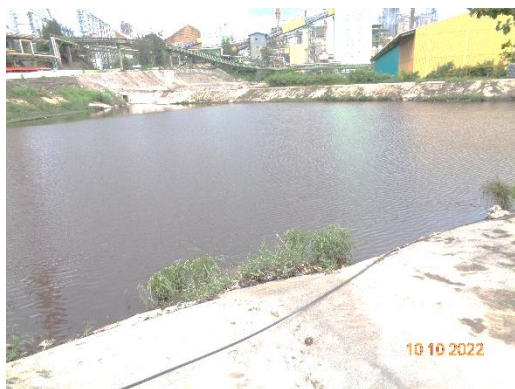
รูปที่ 2 - 24 บ่อสามเหลี่ยมขนาด 20,000 ลบ.ม.
