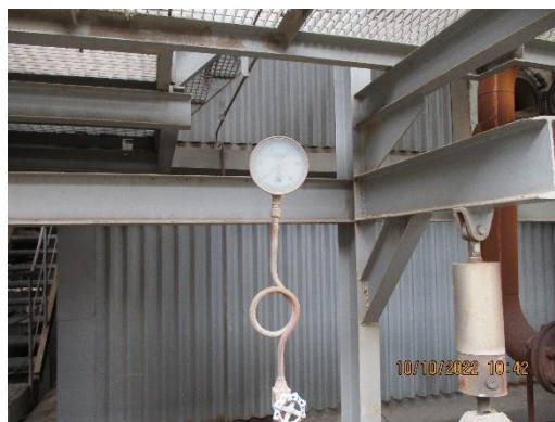
รูปที่ 2 - 55 Pressure gauge ของหม้อไอน้ำ
