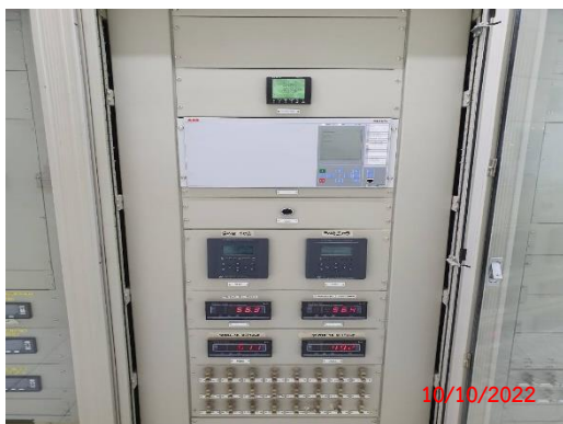
รูปที่ 2 - 5 ติดตั้งอุปกรณ์ AMR
