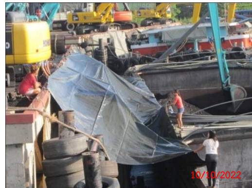
รูปที่ 2 - 35 การปูผ้าใบระหว่าง เรือ Barge และท่าเรือ
