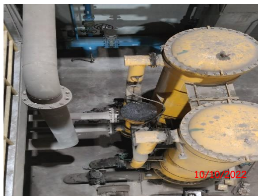
รูปที่ 2 - 66 DC Oil Pump ภายในโรงไฟฟ้า
