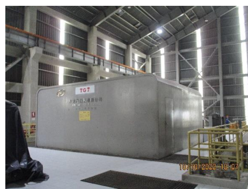
รูปที่ 2 - 21 เครื่องผลิตกระแสไฟฟ้าในอาคารปิด
