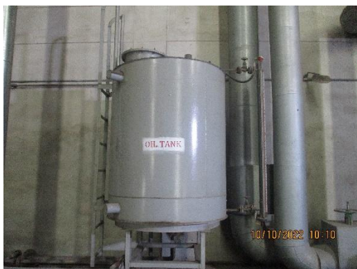
รูปที่ 2 - 65 Emergency Gravity Oil Tank
